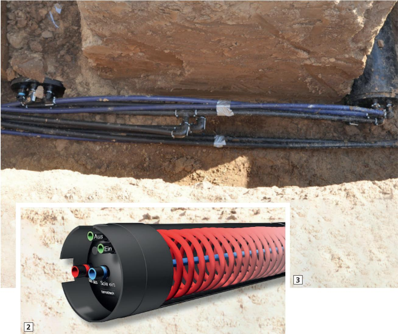
**2** Die thermodynamische Besonderheit des TerraTech-Geothermie-Absorbers liegt in der Zweistofffüllung, nämlich Wasser und Sole: Ähnlich einem Eisspeicher ist das einzelne Zylinderelement von 6 m Länge und 32 cm Durchmesser mit Wasser gefüllt. Die Sole führende Kunststoffrohrspirale im Zylinder geht als Vorlauf zur Wärmepumpe ab.
